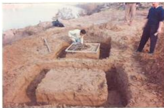
شکل ۵. بلوک‌های آماده آزمایش
