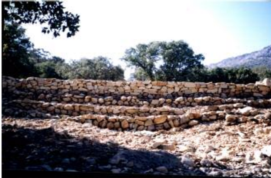
شکل ۳. یکی از سدهای اصلاحی آبراهه تنگ تیر
